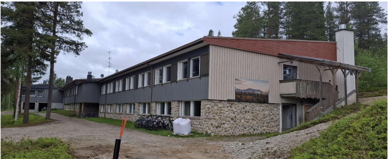
Kuva 21. Rakennuksen kaakkoispäädyssä on näkyvissä julkisivujen aikaisempaa väritystä.
