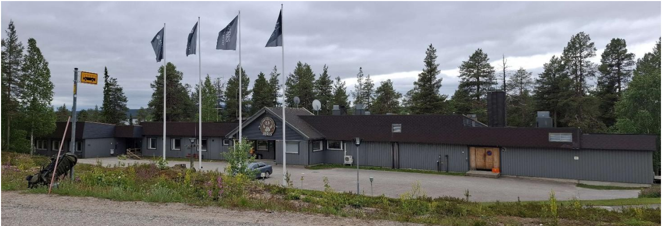
Kuva 16. Näkymä Jerisjärventieltä Jerishotellille. Hotelli sijaitsee Jerisjärven suuntaan viettävässä rinteessä, selvästi tietä alempana. Hotellin edustalla on runsaasti asfaltoitua pihatilaa pysäköintiä varten. Koillisen suuntaan avautuva sisäänkäyntijulkisivu on ilmeeltään suljettu.
