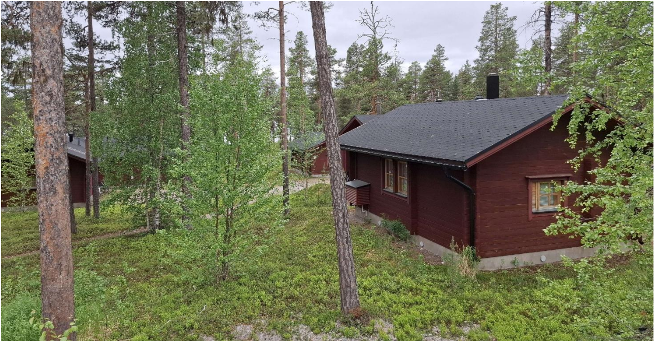
Kuva 29. Vanhemmat majoitusrakennukset sijaitsevat Jerisjärveä kohti viettävässä rinteessä. Rakennuksia ympäröi harvahko mäntymetsä.
