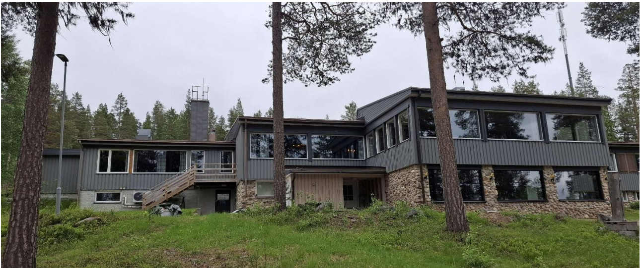
Kuva 20. Julkisivu lounaaseen. Ensimmäisessä kerroksessa julkisivut on verhoiltu luonnonkivillä. Toista kerrosta hallitsevat järvmäisemaan avautuvat suuret ikkunat.
