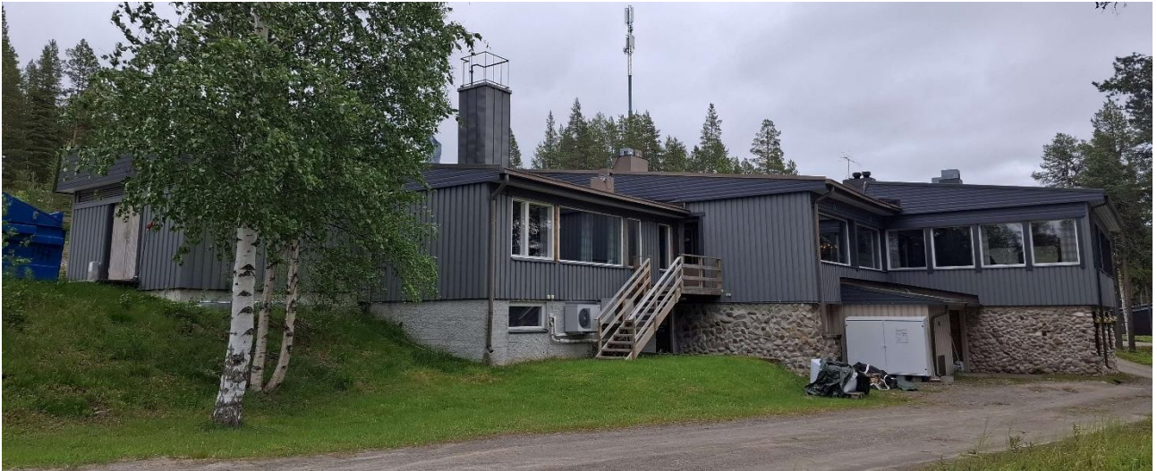
Kuva 19. Pääty luoteeseen. Kattomuoto, viistot koteloidut räystäät ja suuret ikkunat viittaavat 1970-lukuun.
